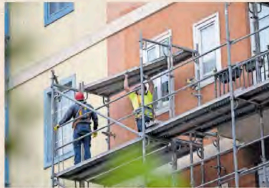
Dos trabajadores montan un andamio en Santander. EFE
